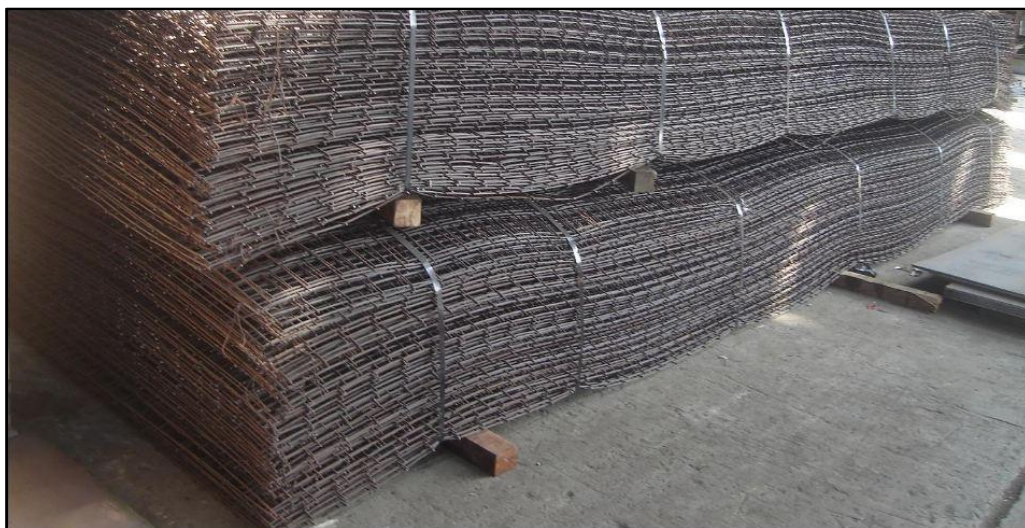
FOTO 2: PANELES DE MALLAS ELECTROSOLDADAS
